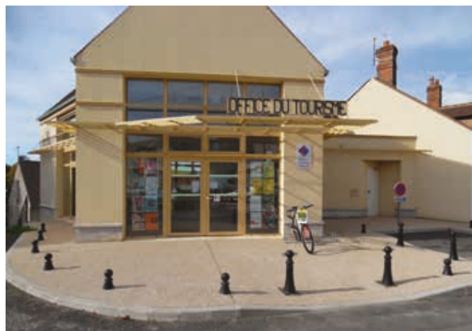
BIT de Souppes-sur-Loing
