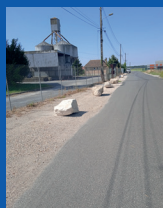
Pose de roches
