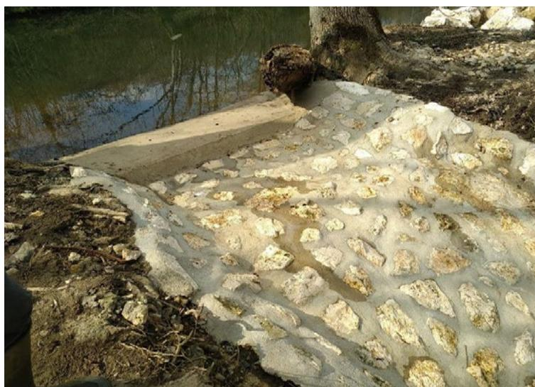
Figure 10 : Travaux RCE sur le Moulin Rouge - Reprise de la maçonnerie du seuil sur le 2nd bras – Sources du Loing
