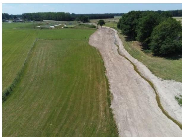
Figure 24 : Remise en fond de vallée et reméandrage de la Bezonde à Nesploy - Bezonde
