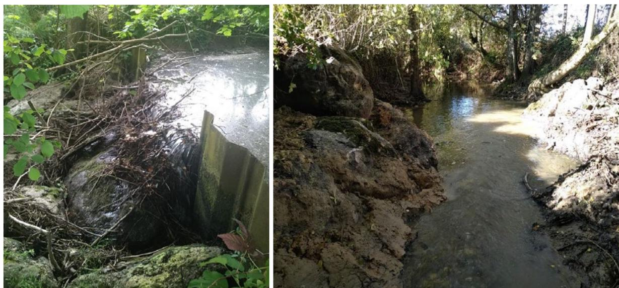
Figure 26 : Retrait des palplanches « des entonnoirs » à Montacher-Villegardin - Lunain
