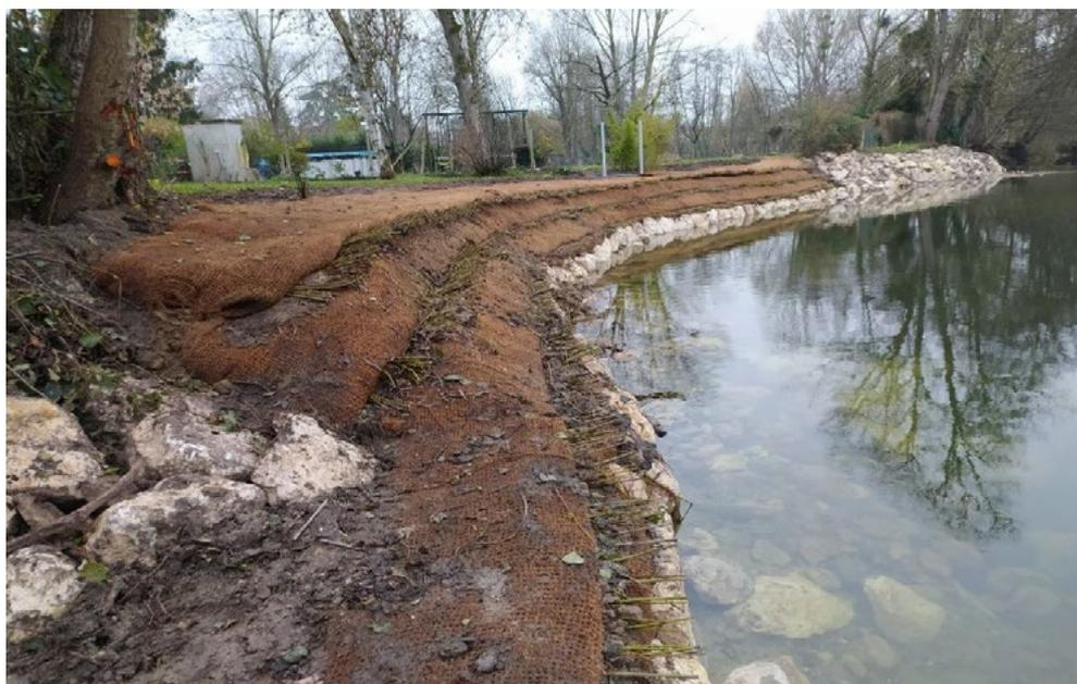
Figure 32 : Travaux de consolidation de berges à Portonville à Bagneaux-sur-Loing – Loing aval
