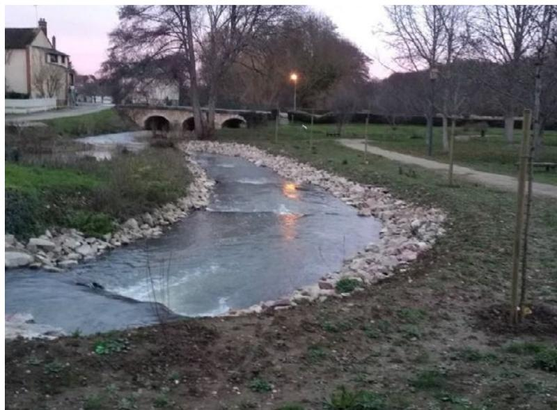
Figure 9 : Travaux RCE à Bléneau - Bras de contournement après travaux (Hiver 2020) - Sources du Loing
