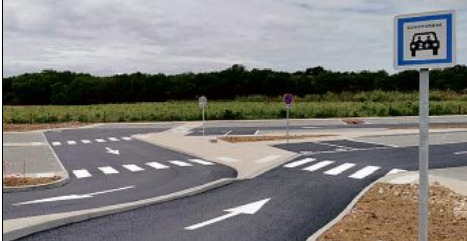
L'aire de covoiturage prête à accueillir ses premiers automobilistes dès le 1 er juillet.
